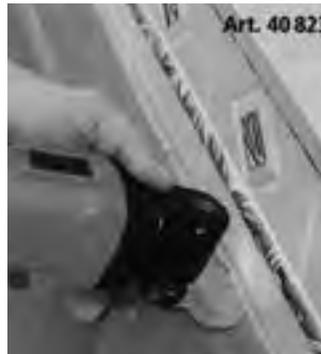
Schadhafte elastische Silikon- oder Acryl-Anschlussfugen werden mit dem pilzförmigen Messer schnell und rückstandsfrei entfernt.
