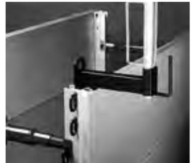
Auflagepratzen zur Sicherung des Verbaus gegen Abrutschen
