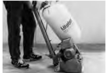
Führen der Walzenschleifmaschine
