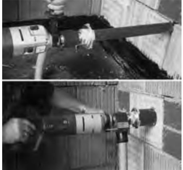
Kernbohrer Trocken 61 mm
