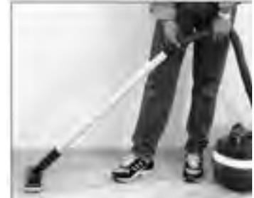
Schleifstaub nach dem Zwischenschliff absaugen
